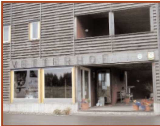
Holzbau-Architektur am Biobauernhof Vetterhof
